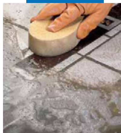
Отделка губкой керамического пола с деревянной вставкой
